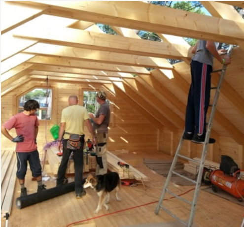
LES COMBLES, AVANT ISOLATION
