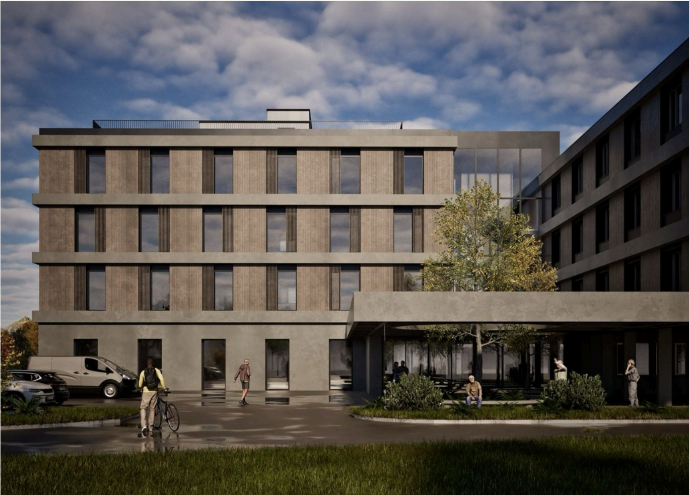
COUR D'ENTRÉE, ENTRE LES DEUX BÂTIMENTS • VISUALISATION © FAHRNY & PARTENAIRES
