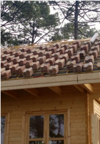
POSE DES TUILES
