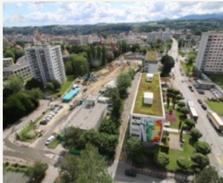
LE CHANTIER EN COURS, VUE AÉRIENNE
