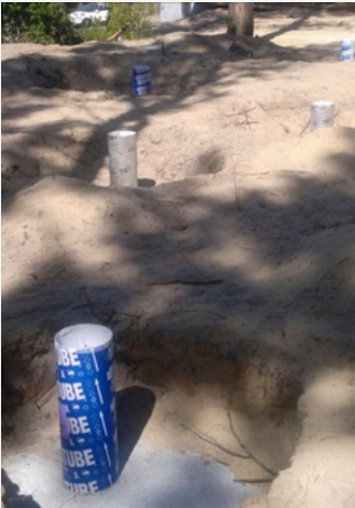
PLOTS DE FONDATION DANS LE SABLE
