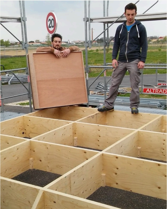
OUATE DE CELLULOSE INSUFFLÉE DANS LES CAISSONS
