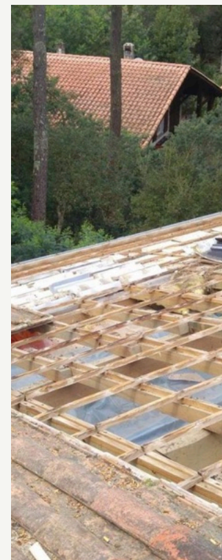
REPOSE DE LA COUVERTURE
