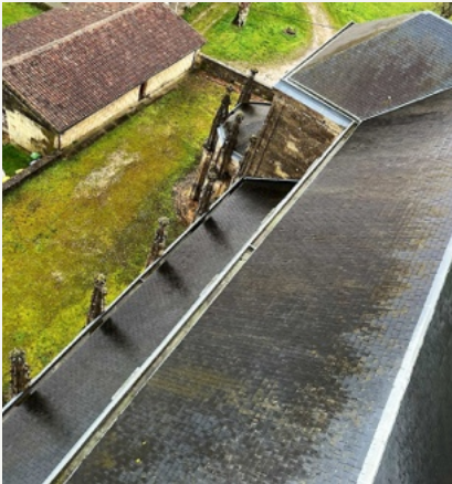
COUVERTURE DE LA NEF, REPRISE EN ARDOISE, VUE DU CLOCHER
