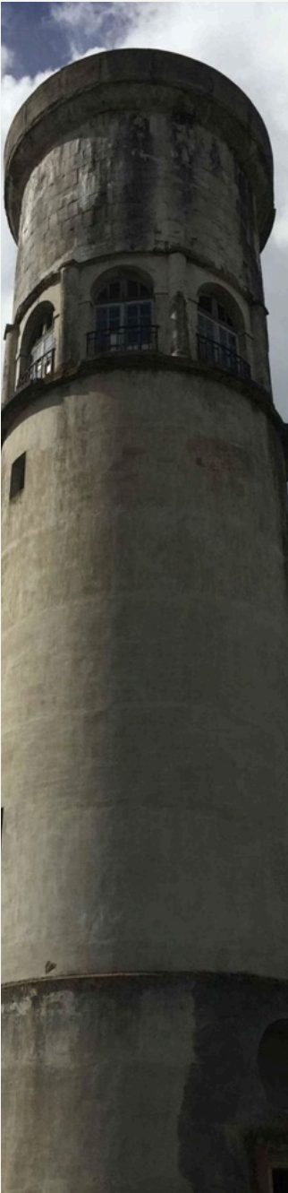
LE CHÂTEAU D'EAU
