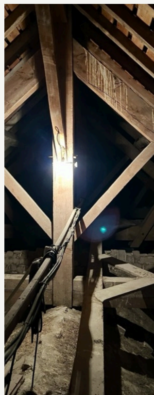
COMBLES DE LA NEF
