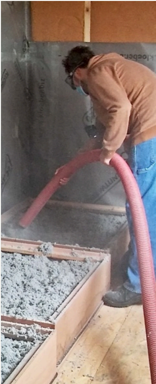
OUATE DE CELLULOSE INSUFFLÉE DANS LES CAISSONS
